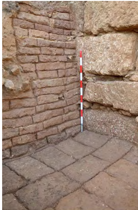
Fig. 6 - Vista del interior de la muralla de Tarraco, con el relleno de adobes (según AQUILUÉ ET AL. 1991, 287, fig. 11).
