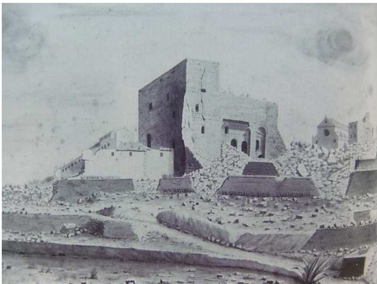
Destrució i runes del Pretori i voltants Col·lecció d'aquareles de Vicenç Roig, exposades a Casa Castellarnau (Tarragona).
